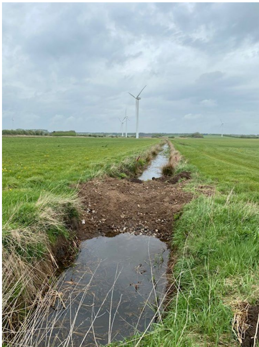
Figur 2.1. Eksempel på blokering af grøft med det formål at hæve vandstanden i projektområdet.
