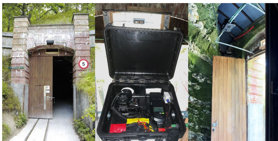
Fig. 1. Indhold (midten) og placering af de to kamerabokse med udflyvningskameraet (tv.) og indflyvningskameraet (th.). På billedet til højre ses desuden over hovedporten til Mønsted Kalkgruber det gennemflyvningshul, der sikrer flagermusene adgang til gruberne. Lystællerens dioderamme er placeret langs yderkanten af gennemflyvningshullet.
