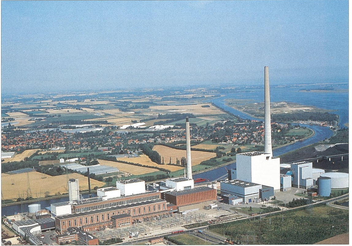
'Fynsværket' power plant.
