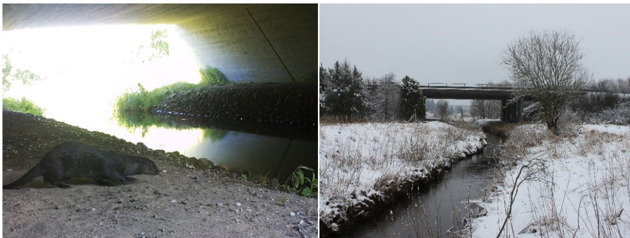
Figur 2.6. Ved anlæg af nye veje eller renovering af broer på eksisterende veje skal der altid anlægges brede banketter langs vandløbet, dels er det de bedst egnede til odder, og dels kan andre arter have gavn af dem (Fotos: M. Elmeros).
