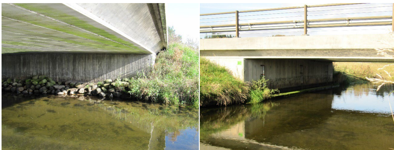
Figur 2.7. Eksempler på midlertidige faunapassager til odder på eksisterende vejbroer anlagt som en række kampesten eller flydepontoner langs broens fundament. Det er vigtigt, at der altid er nem adgang mellem vandfladen og faunapassagen for odder. Faste hylder er ineffektive og ofte helt uegnede for odder (Fotos: M. Elmeros).
