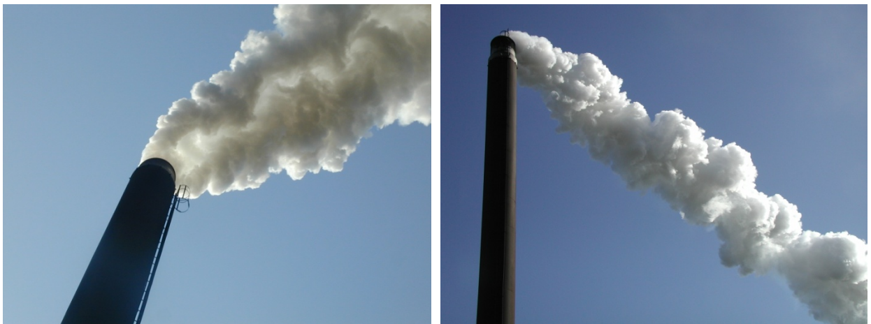
Figur 1. Røgfanen indeholder øjensynlig vanddråber allerede i skorstensmundingen.
