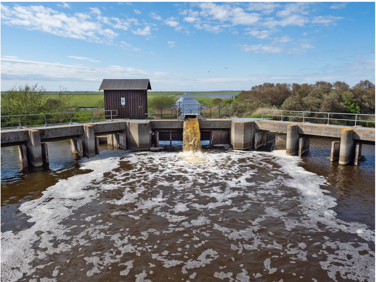
Foto 1. Pumpen, der blev indkøbt i 2020, blev taget i brug i dagene 26.-30. maj efter en periode med meget nedbør. Vandstanden blev på denne måde reduceret fra et niveau på -14 cm DVR90 til -20 cm DVR90. Pumpen kan pumpe op til 300 liter/sekund. Foto er taget 27. maj.
